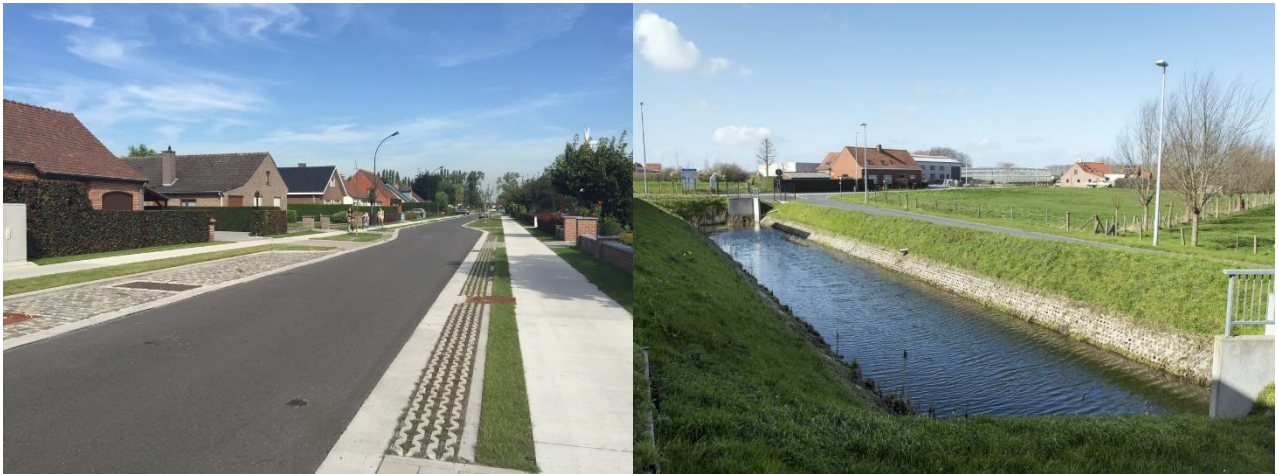
Figuur 54: Links: Lokale infiltratie wegverharding en fietspad. Rechts: Infiltratiebekken
