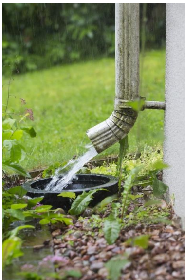
Figuur 52: Afkoppelen dakafvoer van het afvoerstelsel
